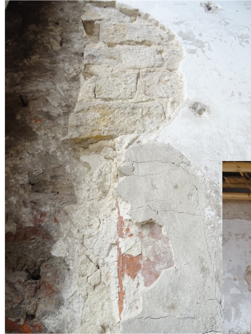
Begane grond, voorkamer: linker zijgevel met klamp en kloostermoppen.
