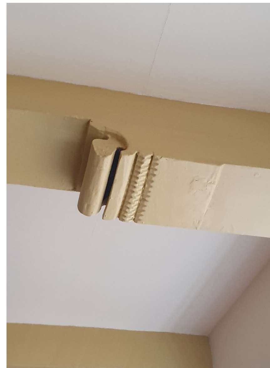
Het eikenhouten sleutelstuk. Oorspronkelijk verbond een korbeel het sleutelstuk diagonaal met de muur of een houten muurstijl.
