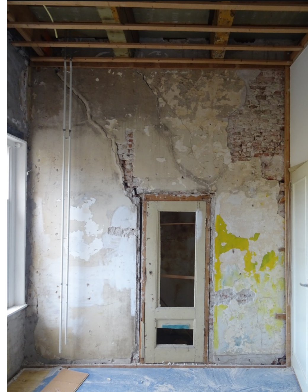
Verdieping, achterkamer: rechter zijgevel.
