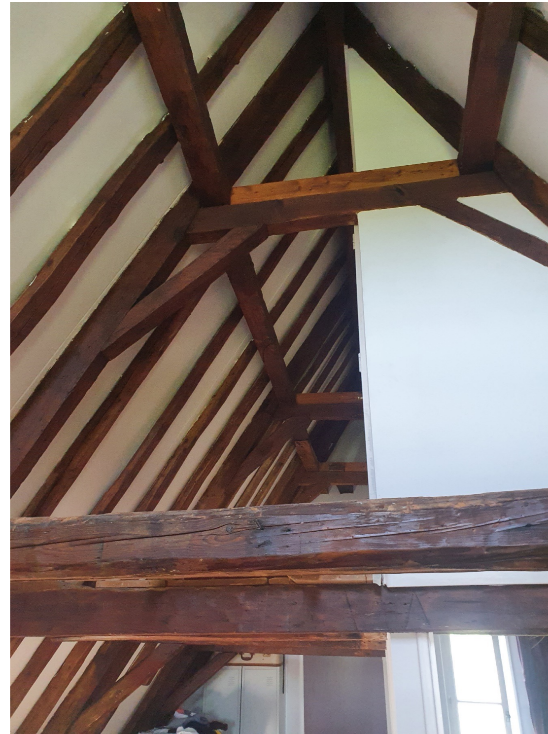
De open zolderconstructie uit 1639–41, bestaande uit door flieringen met elkaar verbonden topspanten met dubbel geschoorde haanhouten. Daarbij lopen de stijlen door van muurplaat tot nok.
