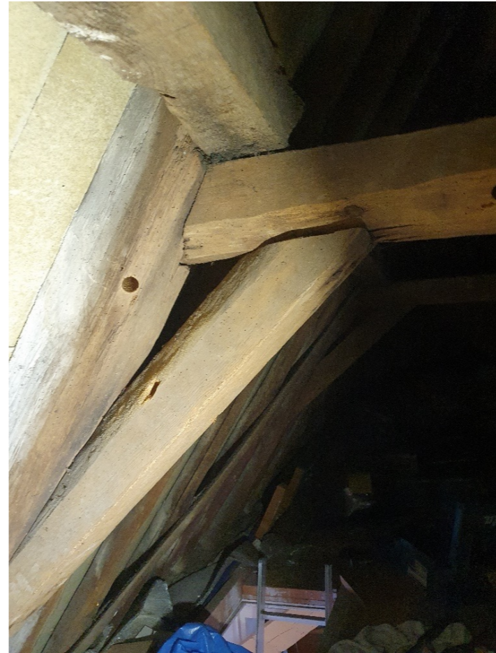
Grenenhouten topspant met een geschoord haanhout. Het boorgat is nog niet afgestopt.
