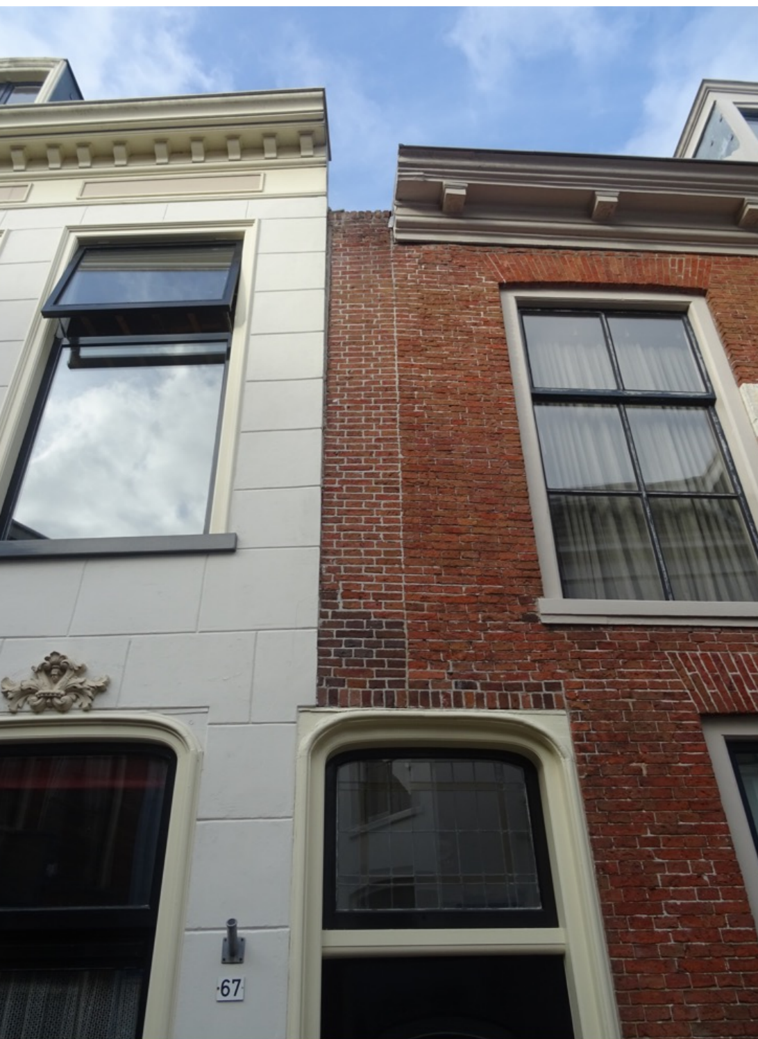
Voorgevels van Grote Kerkstraat 67 en 69. De voordeur van nr. 67 zit ter plekke van een voormalige steeg, waarachter zich nu de gang bevindt. Beide panden zijn ter hoogte van de verdieping over de steeg heen gebouwd.
