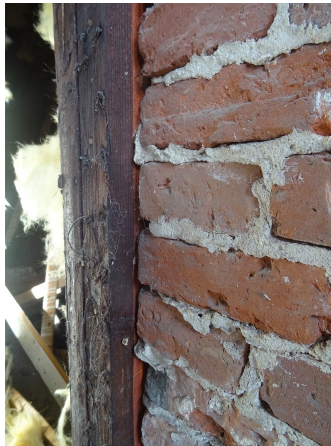
Verdieping, voorkamer: rechter zijgevel met vuren kozijn in loodmenie van vroegere kast. Het metselwerk heeft een net hoekverband met het kozijn en lijkt dus van dezelfde bouwfase.
