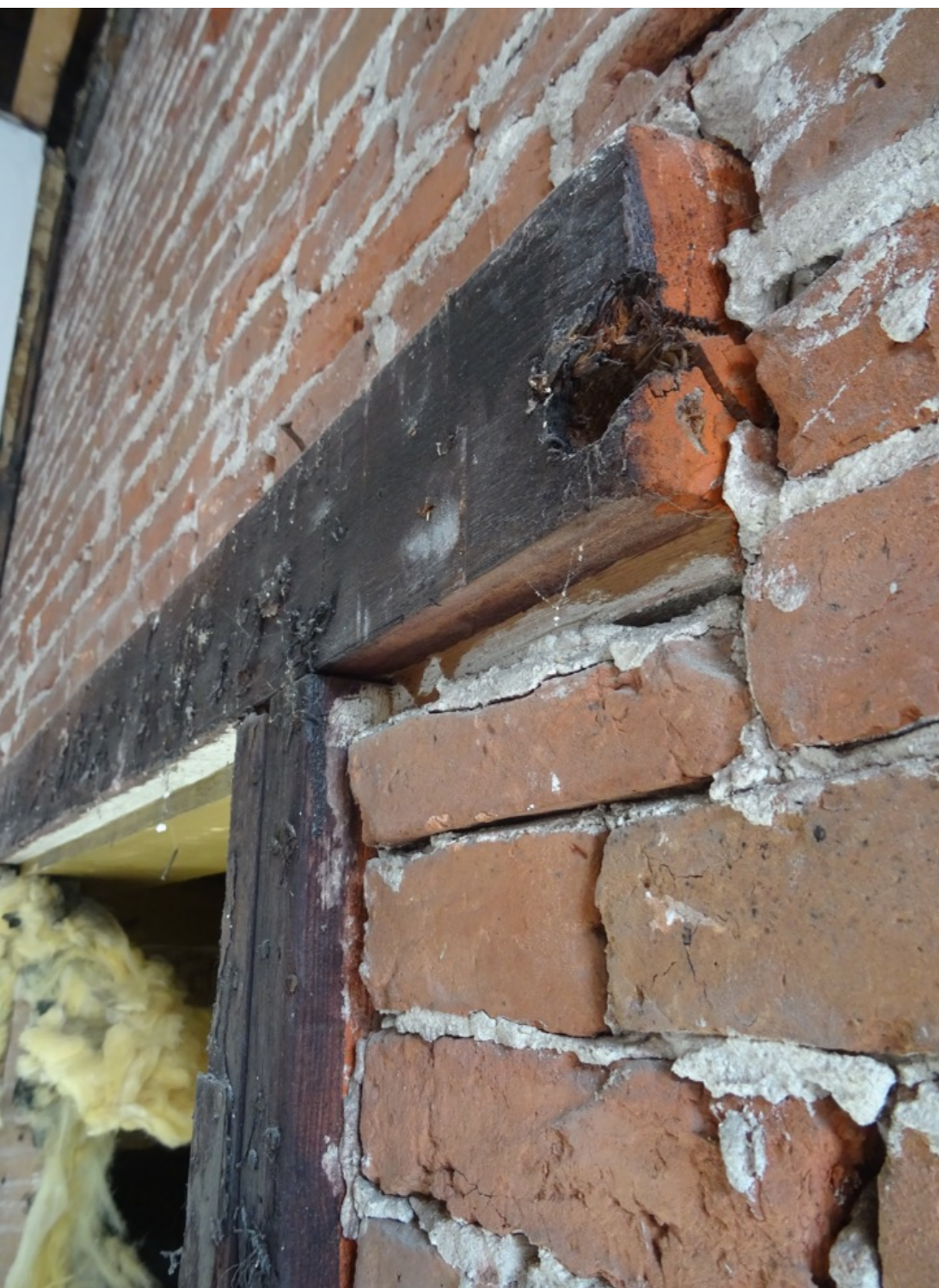
Verdieping, voorkamer: rechter zijgevel met vuren kozijn in loodmenie van vroegere kast.
