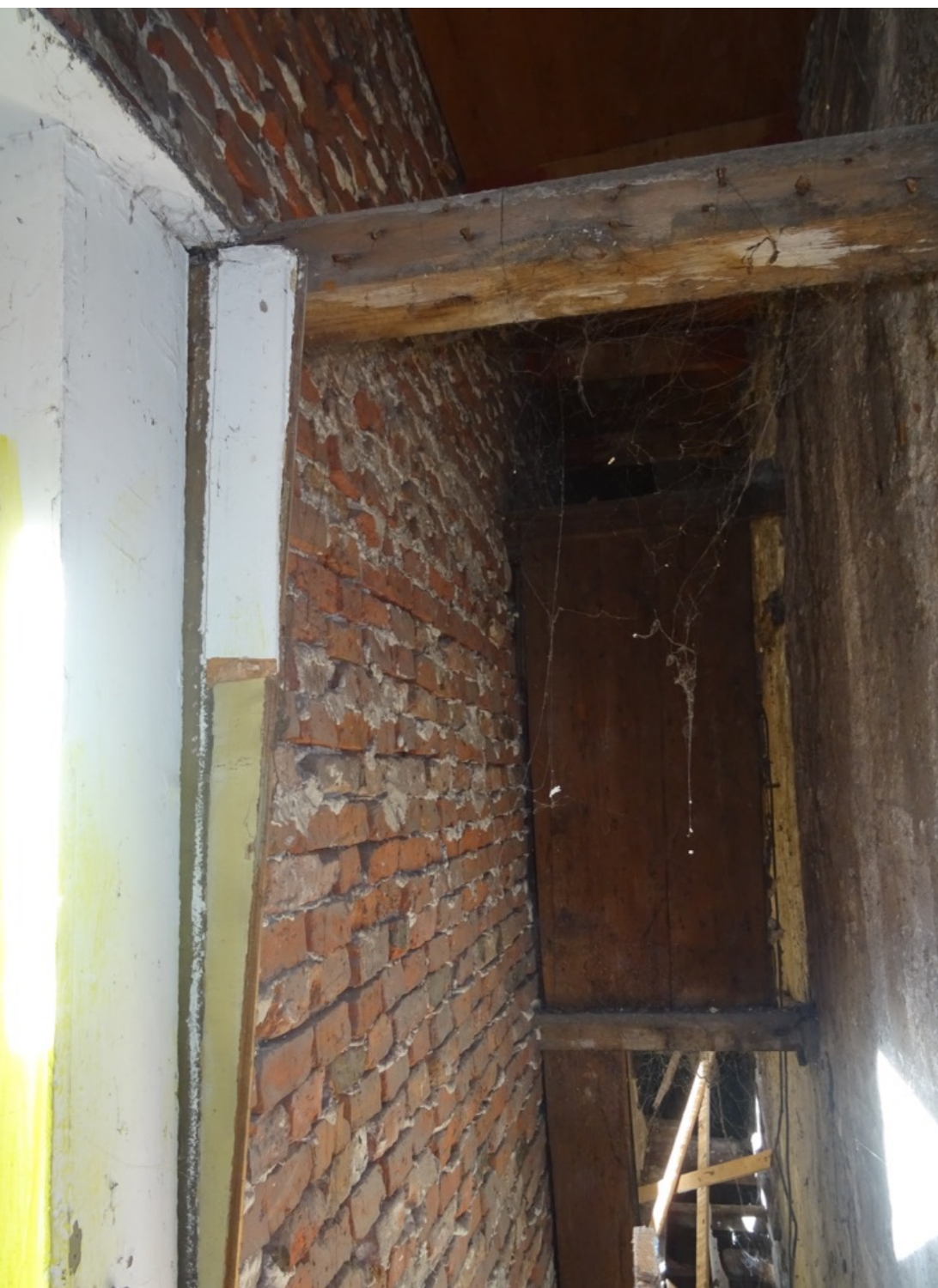
Voormalige steeg ter hoogte van de verdieping. Links het vuil metselwerk van Grote Kerkstraat 67. Rechts de gepleisterde zijgevel van Grote Kerkstraat 69. Op de achtergrond de zijwand van een uitgebouwde kast.
