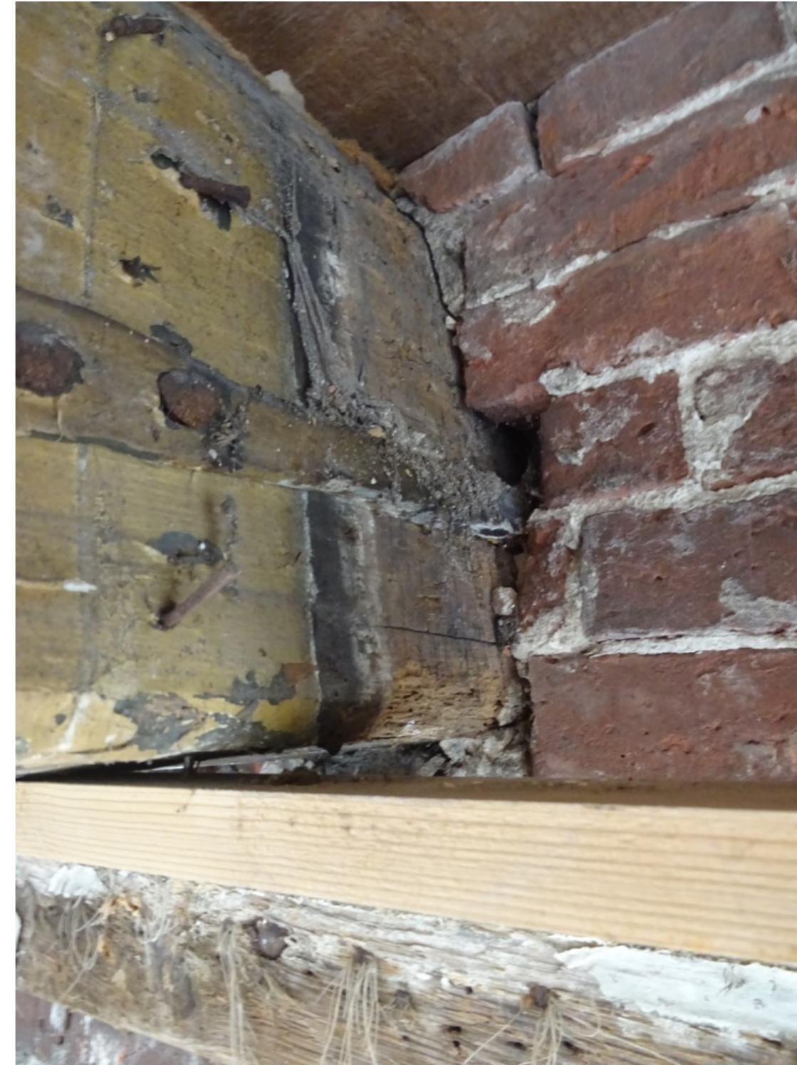
Verdieping, voorkamer: rechter zijgevel met balkkop en anker. De eiken balk dateert van 1598–99. De aftekening van een oudere muur is zichtbaar. Het metselwerk in rode baksteen dateert waarschijnlijk uit 1850–1875. Het is duidelijk om de bestaande balk heen gemetseld.
