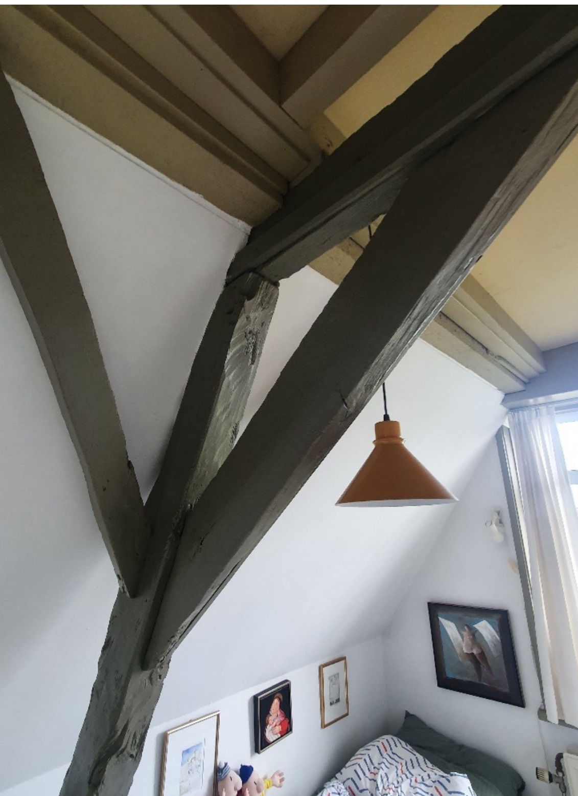
Een schaargebint van de hergebruikte eikenconstructie van de zolder.
