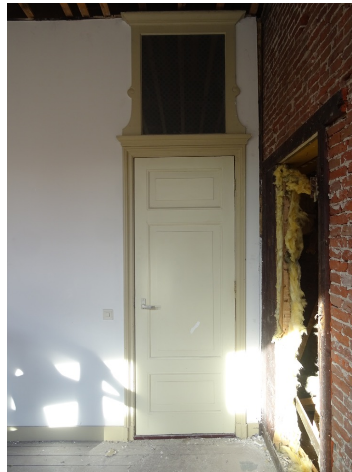
Verdieping, voorkamer: tussenwand van de middenzone met paneeldeur, architraaflijst en sopraorte met mousselineglas. Alles waarschijnlijk uit 1850-1875.
