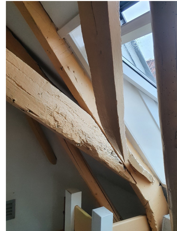
Het kromstijlgebint is niet heel zwaar uitgevoerd, maar heeft toch al zo'n 550 jaar dienst gedaan. Een zolderconstructie met deze ouderdom is voor Leeuwarden een unicum.
