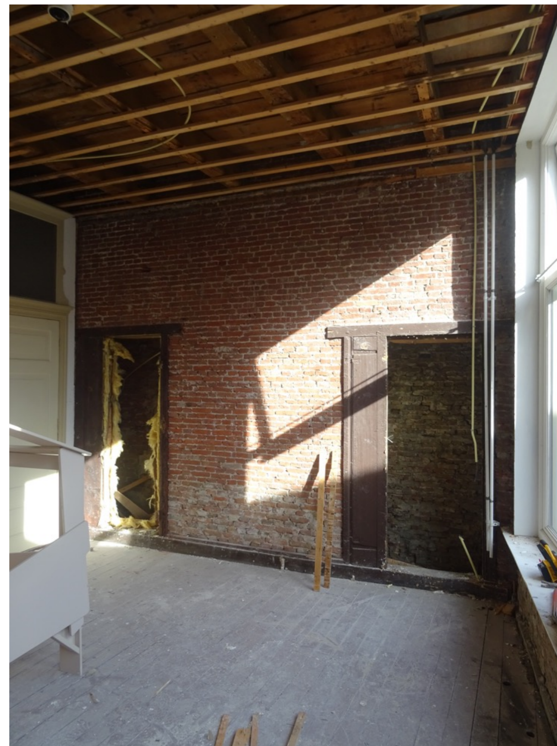
Verdieping, voorkamer: rechter zijgevel met kozijnen van vroegere kasten.
