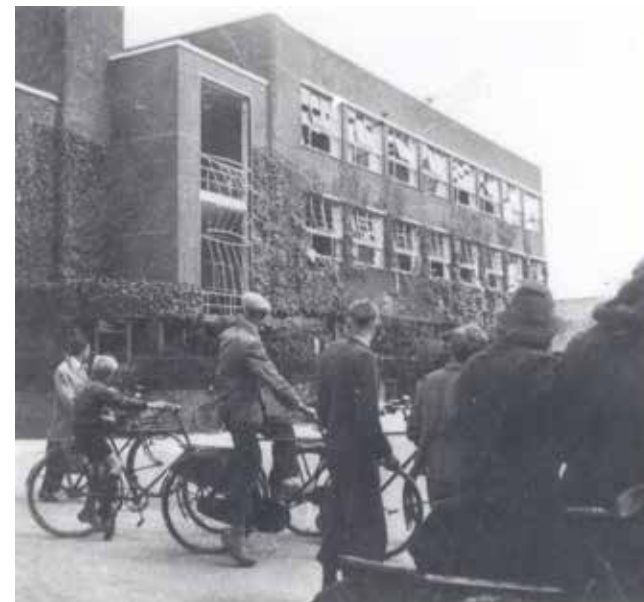
Publiek kijkt naar de schade die is aangericht door bominslagen in het gebouw van de MTS, juni 1942.
