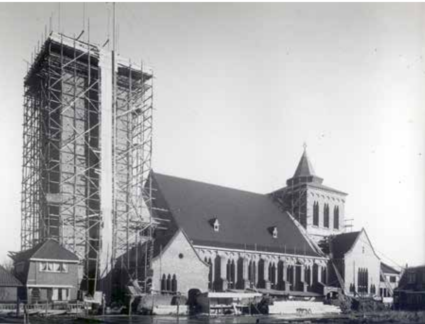
Tijdens de bouw van kerk en toren in 1936.
