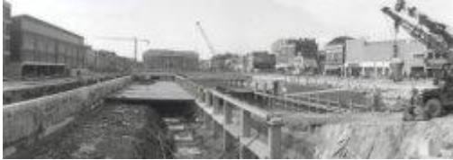
Wilhelminaplein, bouw parkeerkelder, 1978, foto Dick van der Heijde jr.
