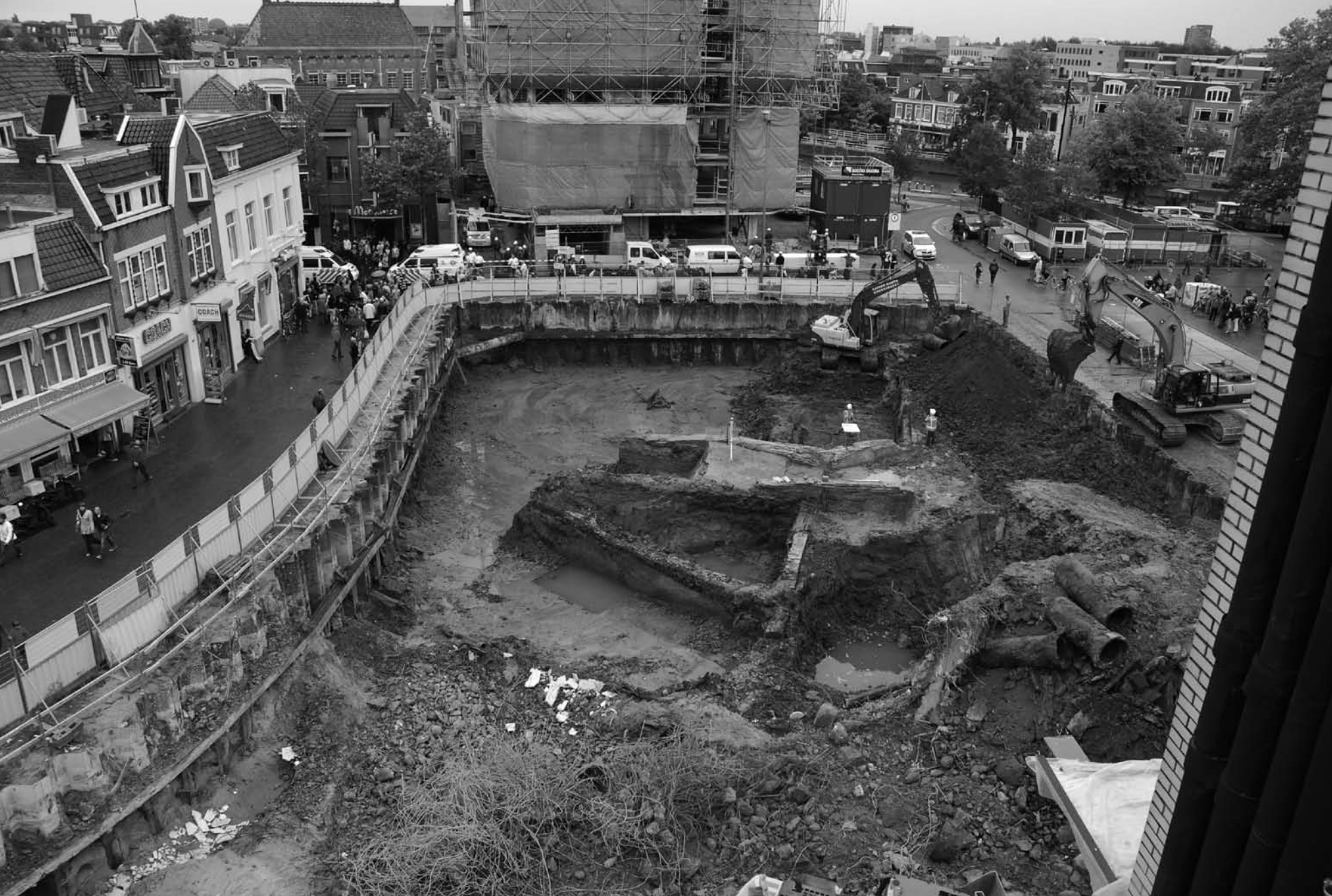
Bouwwerkezaamheden boden in augustus 2010 gelegenheid tot het doen van archeologisch onderzoek naar de afgebroken Wirdumerpoort.
