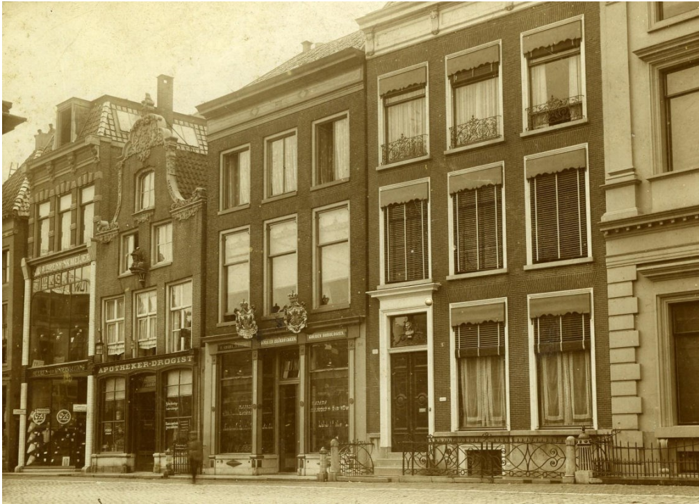
Het in de dertiger jaren van de vorige eeuw t.b.v. de nieuwbouw van warenhuis Vroom&Dreesmann gesloopte pand - met borstbeeld in het bovenlicht van de entree - alwaar tot in de 18 de eeuw de gerenommeerde herberg 'Het Verhulde Hooft' in gevestigd was.
