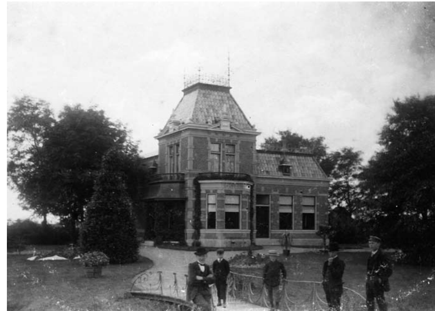
De villa 'Baens Ein' stond aan de Marssumerdijk en markeerde het eind van de harddraversbaan. Hier een foto uit circa 1900.
