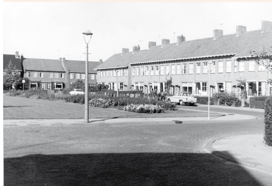
Een deel van de Vosseparkwijk ligt aan de andere kant van de rondweg. De straten rondom het parkje aan de Betje Wolffstraat en de Aagje Dekenstraat hebben een keur aan fraaie woonhuizen.
